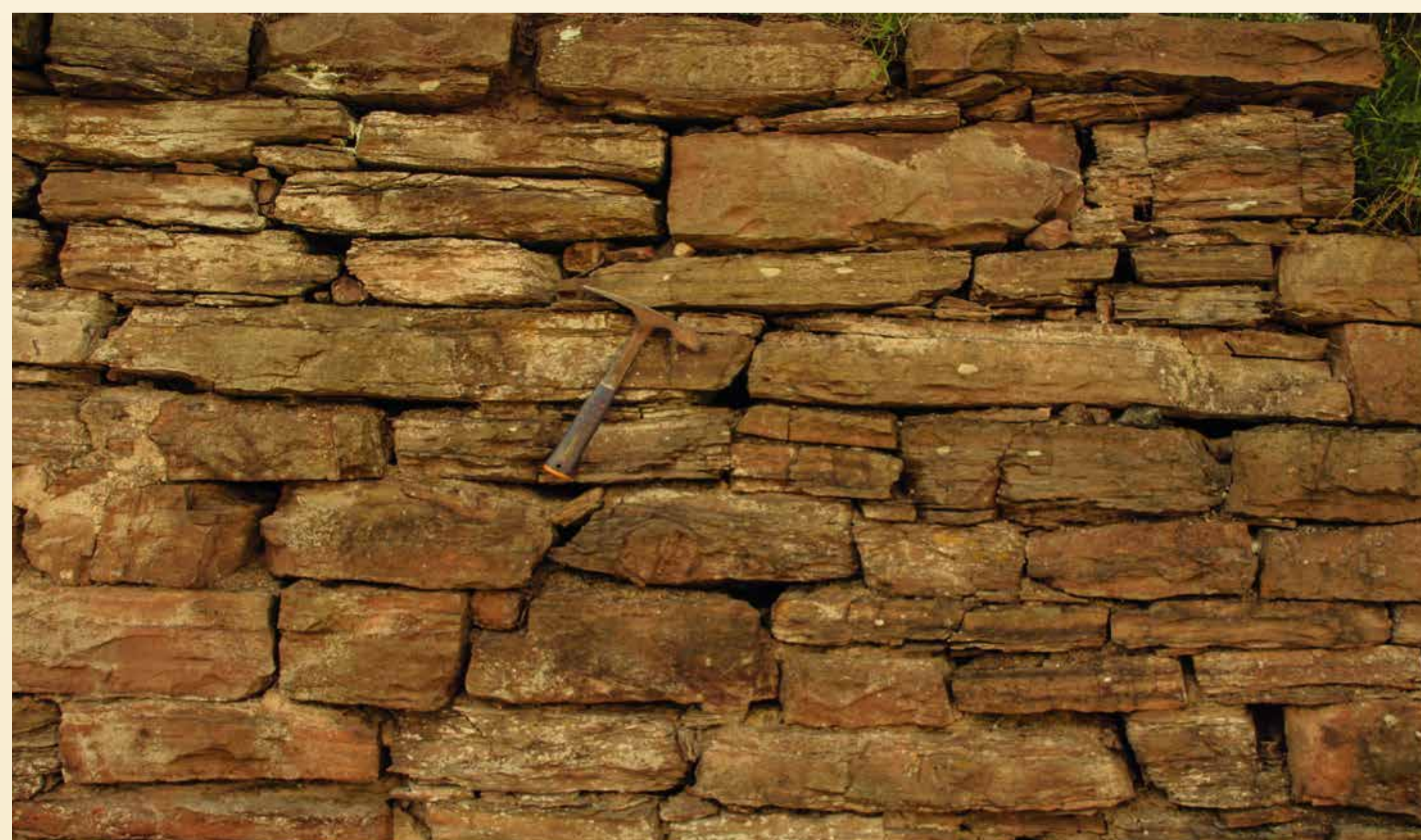
Abb. 1: Waldplatten am Ufermauerbereich der Spitter in der Ortslage von Tambach-Dietharz Fig. 1: Rough slabs as river bank reinforcement along the Spitter in Tambach-Dietharz
